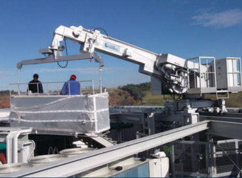
Torre Iberdrola, Bilbao
